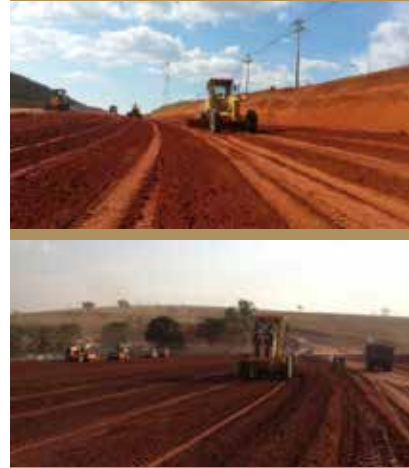
Regularização e reforço do subleito
