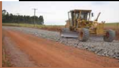
Figura 4: Execução das camadas do pavimento
