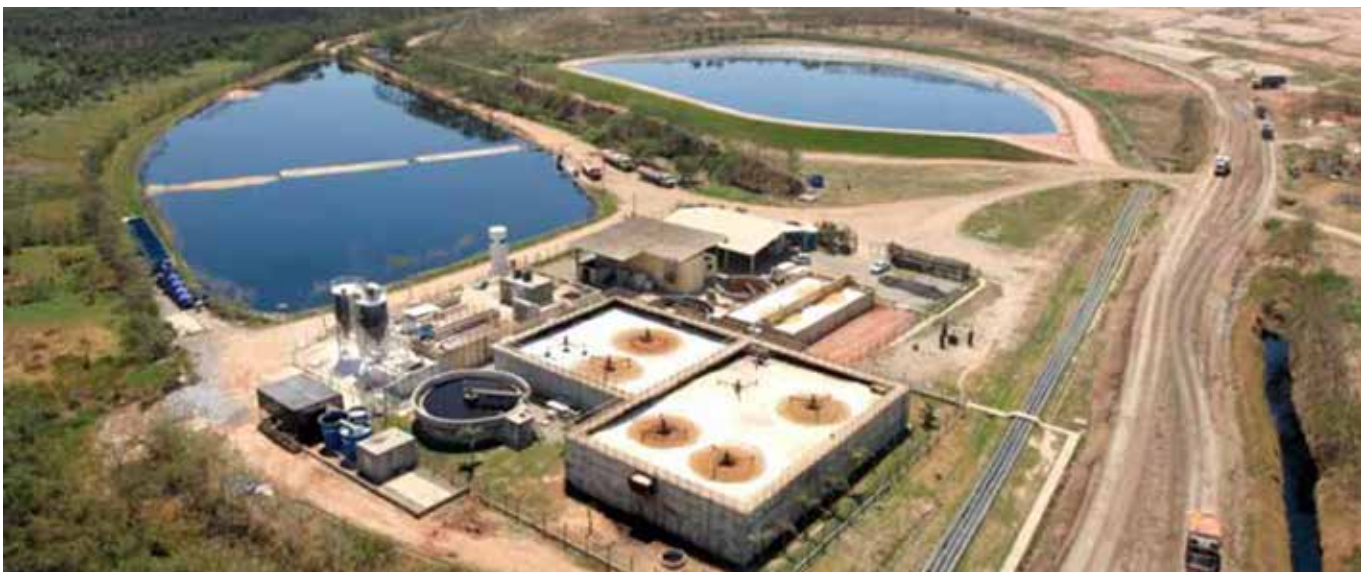
Figura 4: AMJG – Estação de Tratamento do Chorume
