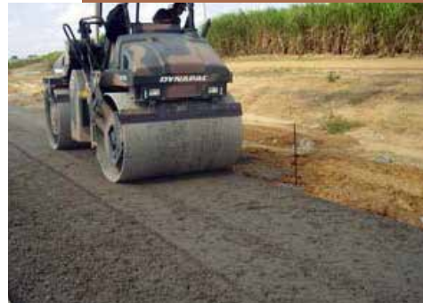
Figura 6: Execução de camada de base de BGS
