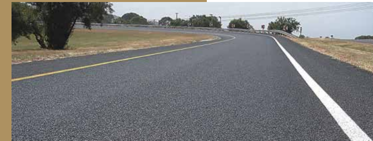
Figura 7: Revestimento de concreto asfáltico
