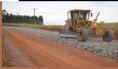
Figura 4: Execução das camadas do pavimento
