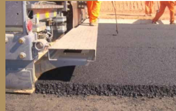
Figura 8: Execução de concreto asfáltico
